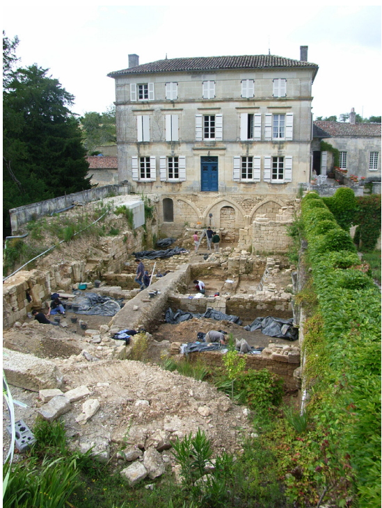
Les fouilles de la salle des moines
